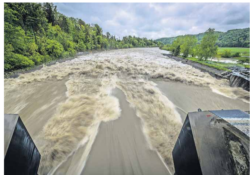
Die Aare in Bern hat die Gefahrenstufe erreicht und bringt in den nächsten Tagen viel Wasser in die Kantone Solothurn, Aargau und schliesslich in die beiden Basel. Im Bild: Die offene Aareschleuse beim Kraftwerk in Niederriet. CHRIS ISELI
