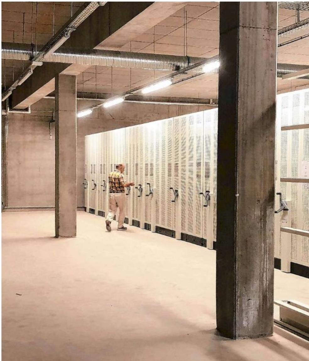
Blick in die Innenräume des Depots (Quelle: Unbekannt)
