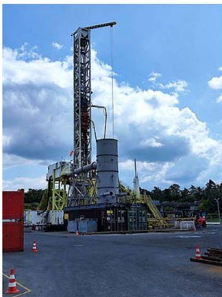
Über Bohrungen wie diese gelangt am Oberrhein heißes Wasser aus mehreren Kilometern Tiefe an die Oberfläche. Neben Wärme und Strom könnte es künftig auch Lithium liefern. Foto: PEE BW
