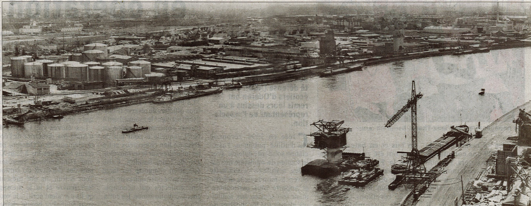
Le pont du Palmrain fête ses 40 ans en ce mois d'octobre 2019. Le chantier a été lancé en 1977. Archive L'Alsace/Eugène GROELLIN
