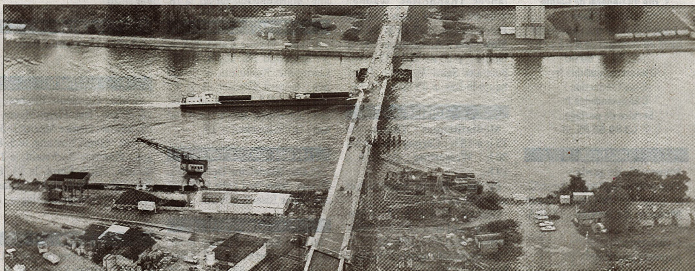
Une vue aérienne du pont du Palmrain en travaux. Archive L'Alsace/Eugène GROELLIN
