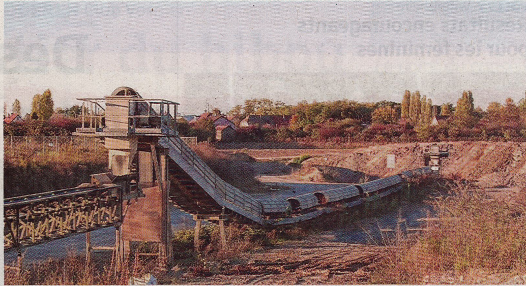
Le Parc des carrières conjuguera les activités humaines (extraction de gravier, trafic aérien, sports et loisirs) et l'écologie. L'exploitation de la carrière Kibag s'achèvera en 2040. PHOTO ANDREAS COURVOISIER
