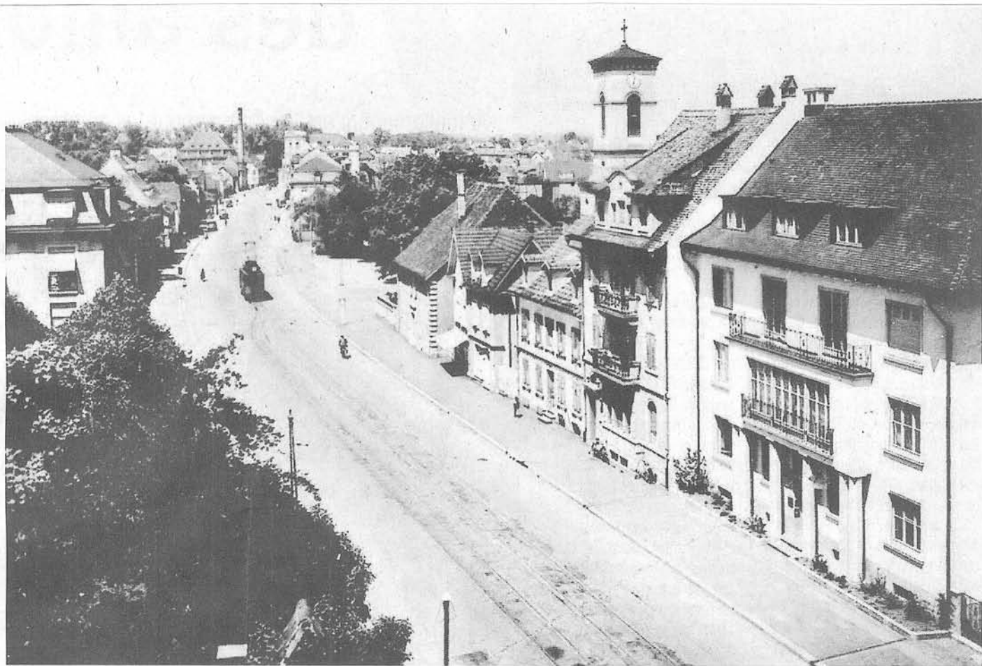
La ligne prolongée. (Photos DNA)
