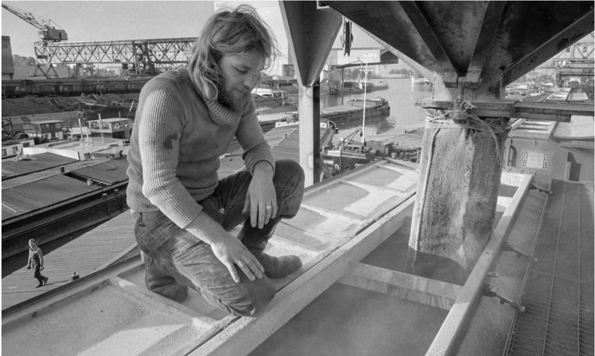
Das Getreide fällt vom Silo direkt in einen Güterwagen der Hafenbahn. Aufnahme vom 04.10.1974. ETH-Bildarchiv
