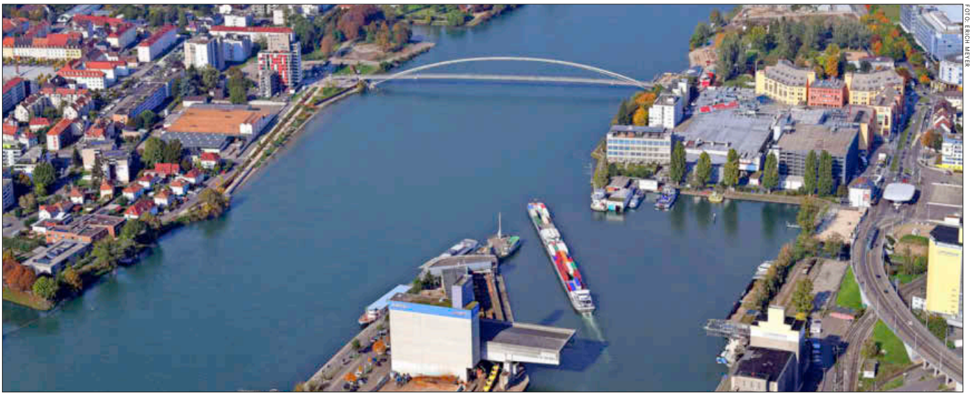
Erst 2007 eingeweiht und schon nicht mehr aus dem Alltag in der Region wegzudenken: Die Dreiländerbrücke verbindet Weil am Rhein und Huningue.
