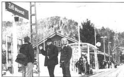
Endstation: das neue Gleis in Zell
