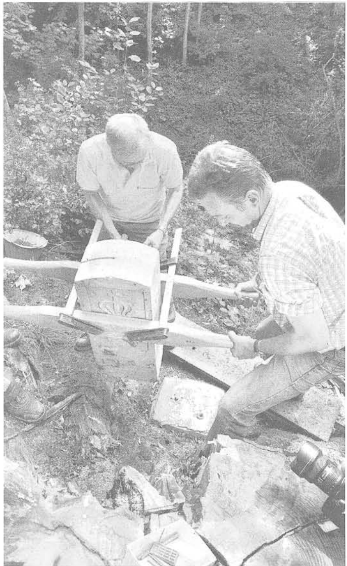
Mit vereinten Kräften. Der gut 80 Kilogramm schwere Grenzstein wird auf sein Betonfundament gesetzt. Foto David Haas
