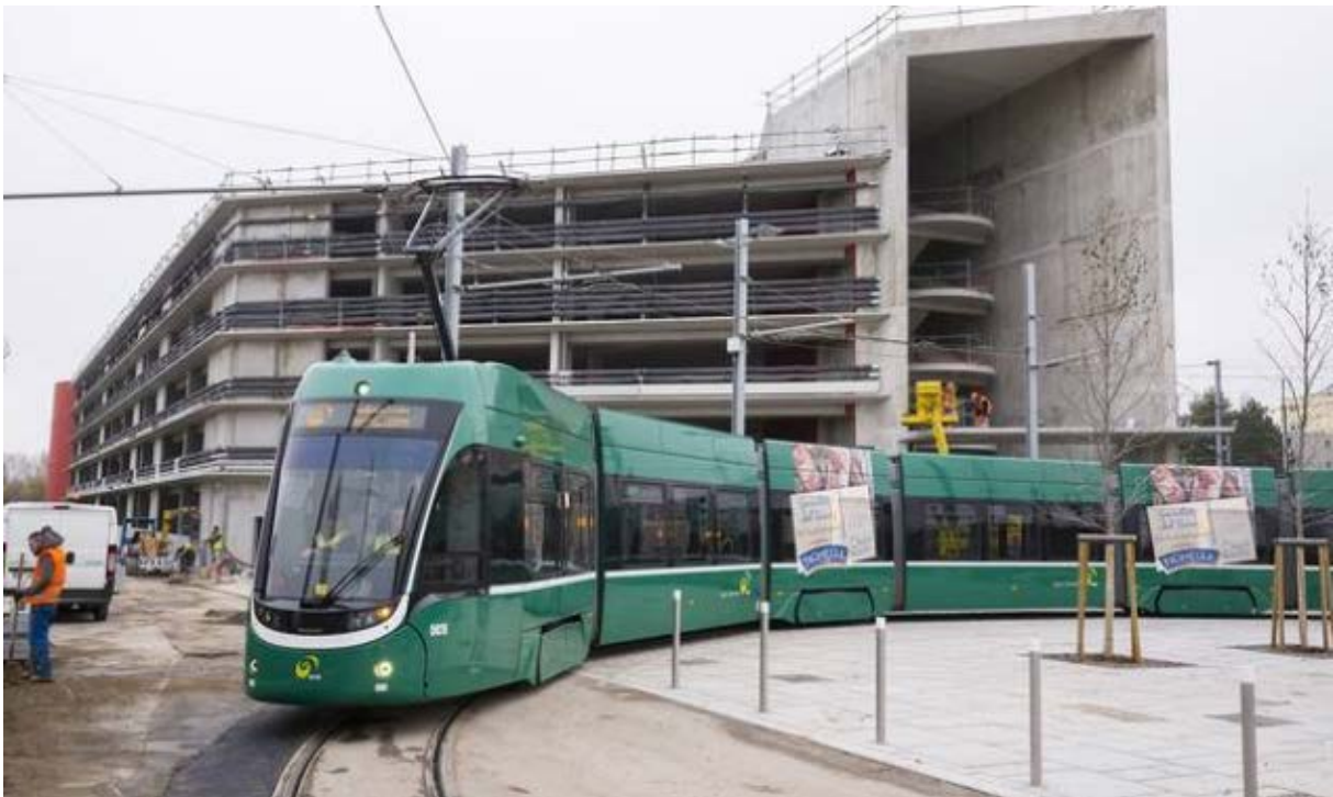
Das Tram gestern Probefahrt an der Endhaltestelle beim Bahnhof von Saint-Louis. Dahinter befindet sich die Park & Ride-Anlage für 740 Autos, die im April 2018 eröffnet wird. © Kenneth Nars
