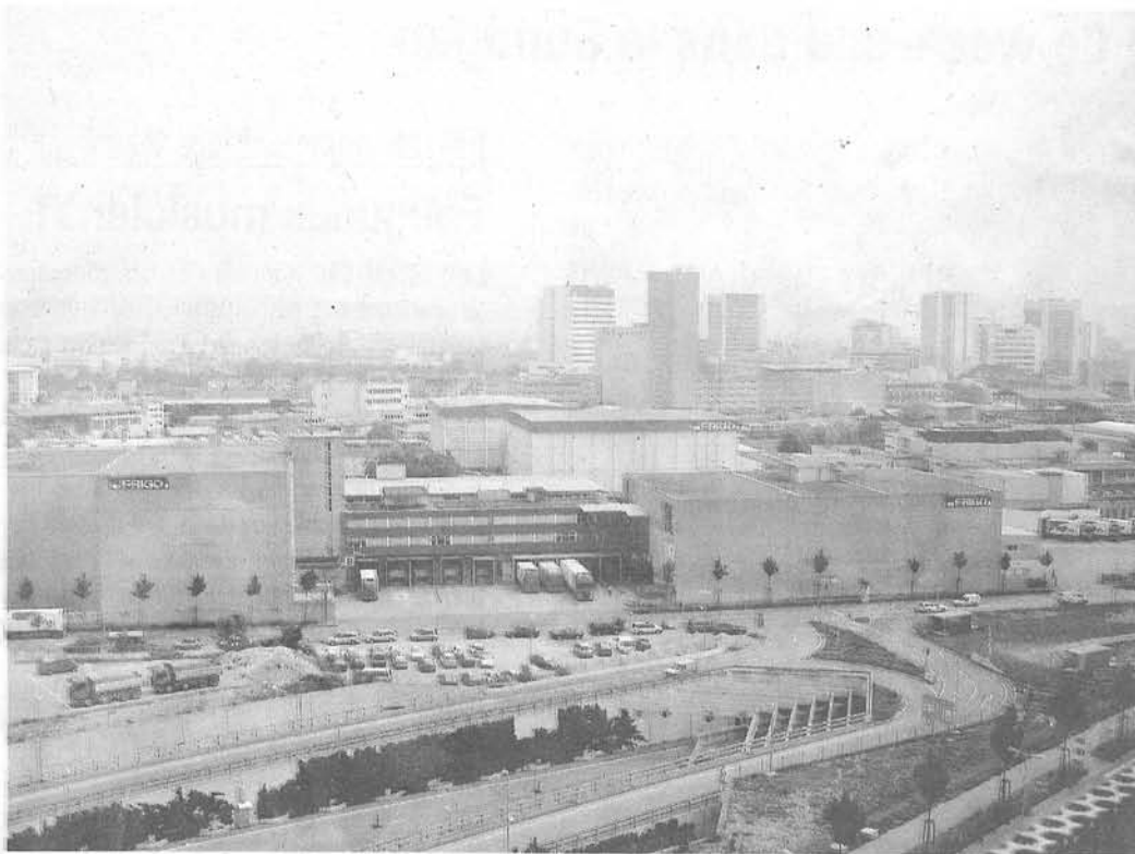
Aménagement du territoire et transports font partie des grands dossiers de Metrobasel et de l'Eurodistrict de Bâle. (Photo DNA)
