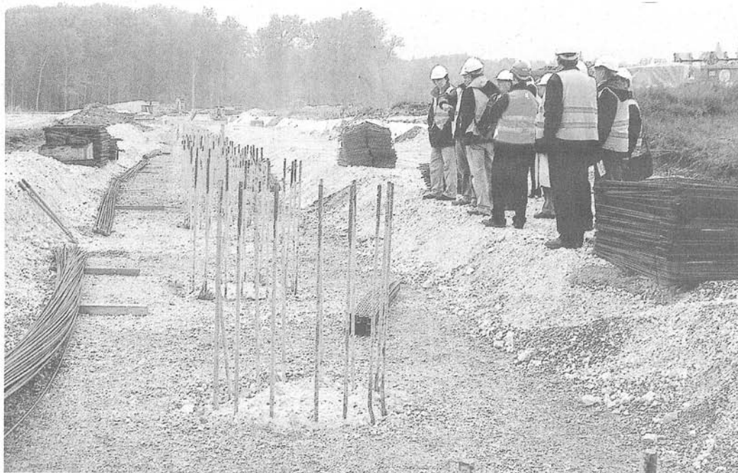
Les fondations de la halle d'excavation (120 x 150 m) reposent sur 60 piliers de 1,20 m de diamètre. Elle couvrira le côté sud de la décharge de 20 000 m 2 , puis le côté nord. (Photo DNA)
