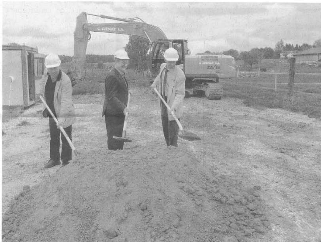
Le coup de pioche symbolique pour le lancement des travaux d'assainissement de la décharge de Bonfol. (Photo DNA)
