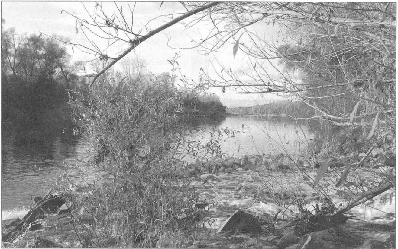
Zwischen Kanderamündung (Foto) und Isteiner Schwellen entsteht ein Rückhalteraum.
