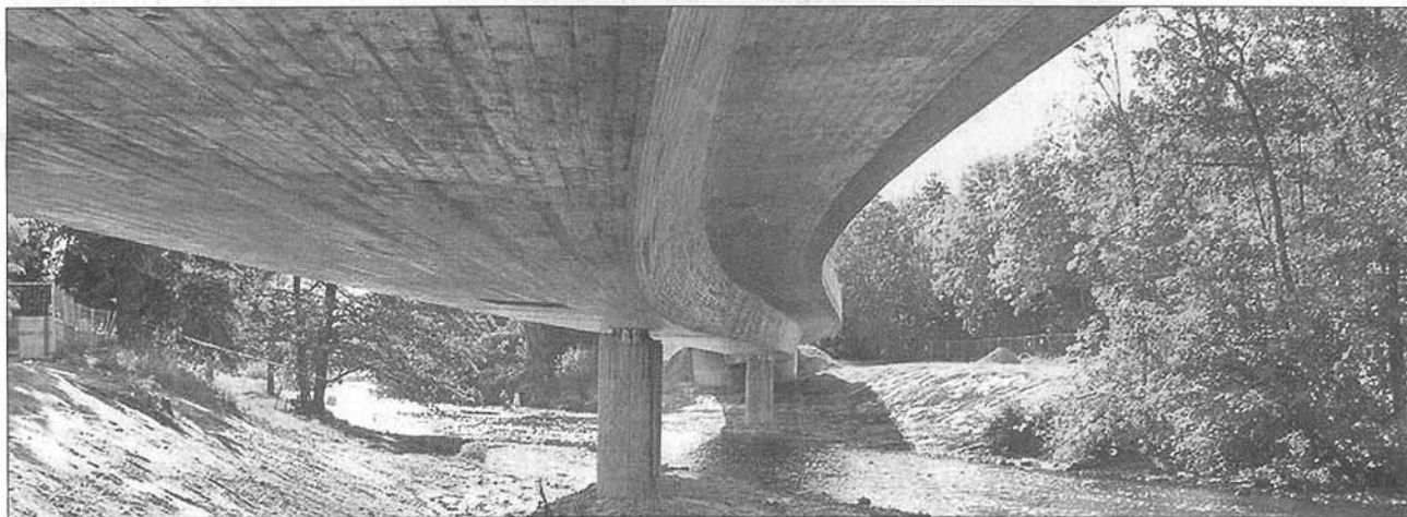
Die Brücke der „Zollfreien“ über die Wiese ist fertig und bietet durchaus auch ästhetische Perspektiven. FOTO: BZ
